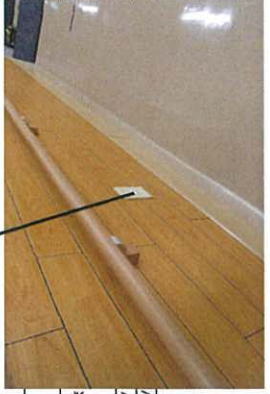
居室前廊下・回らんスペース (吸引・酸素吸入器の接続)
